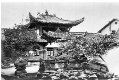
建院前修建的玉皇楼，曾一度作为传染科使用。20世纪80年代因医院改扩建而拆除
